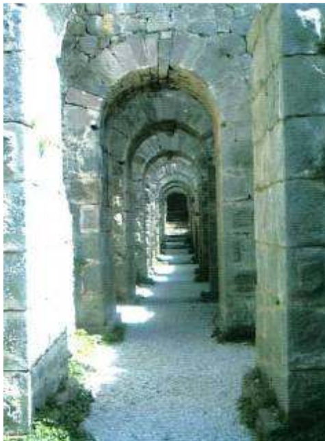
Traian Tapınağı'nın Tonozlu Yapısı
